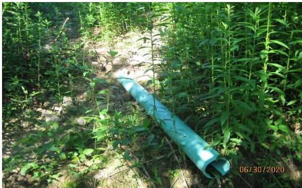
Luzerne Mine Discharge Pipe
